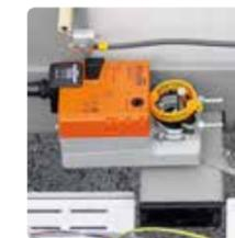
Automatische Zu- und Abluftklappen
