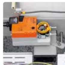
Automatische Zu- und Abluftklappen
