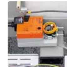
Automatische Zu- und Abluftklappen
