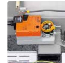
Automatische Zu- und Abluftklappen
