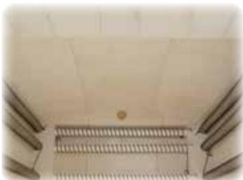
Voûte autoportante robuste, maçonnée selon le principe de la clef de voûte
